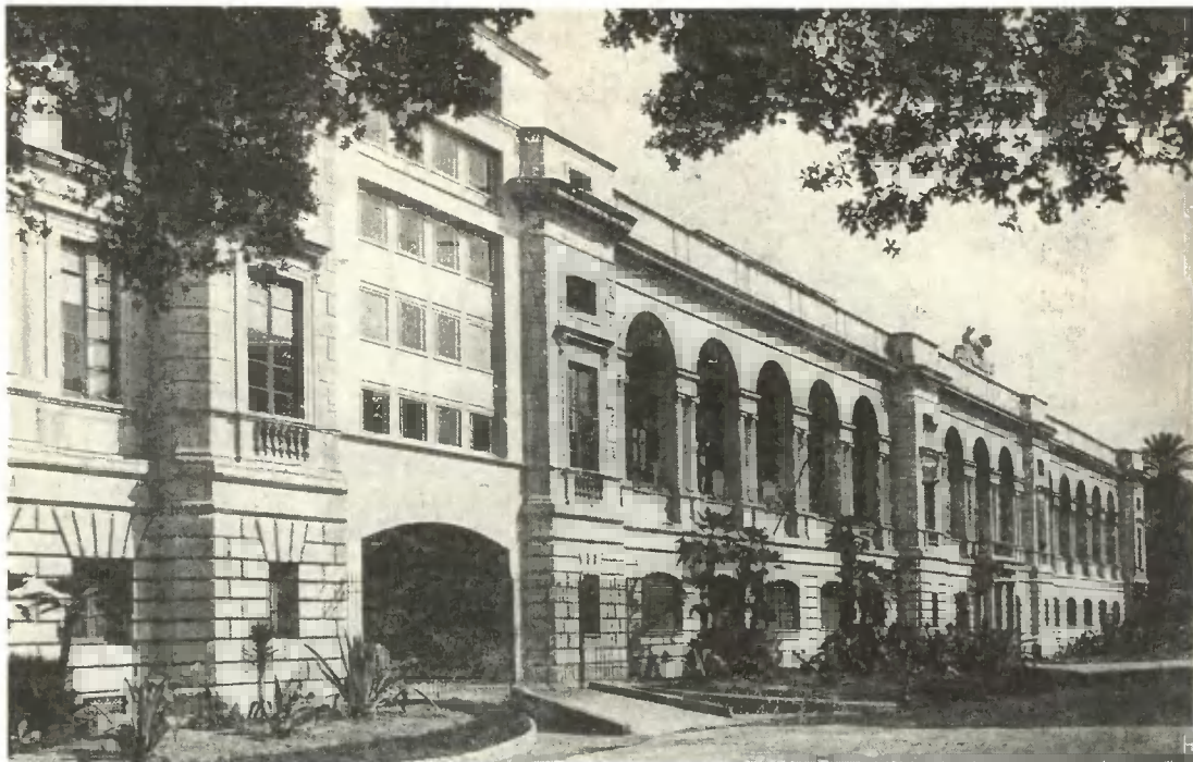
Современное здание станции.
